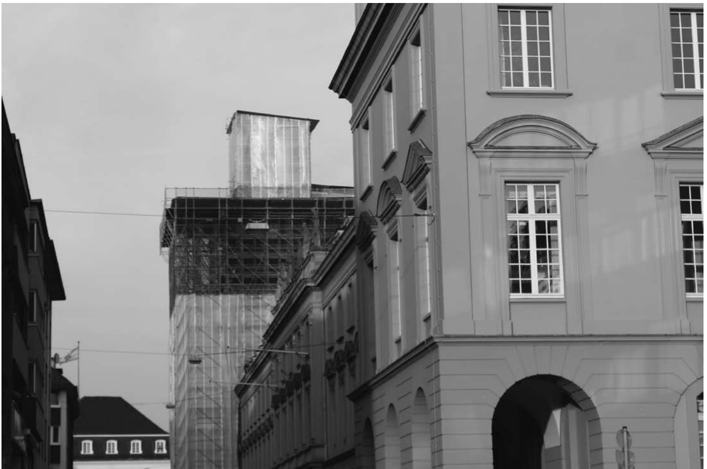
Eine unendliche Geschichte: Die Sanierungsarbeiten am Hauptgebäude in der Bonner Innenstadt.
